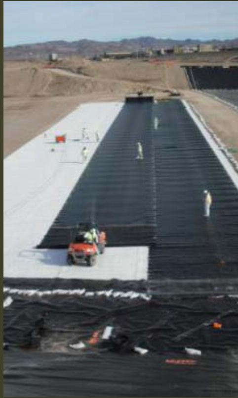
Geomembrane Installation
